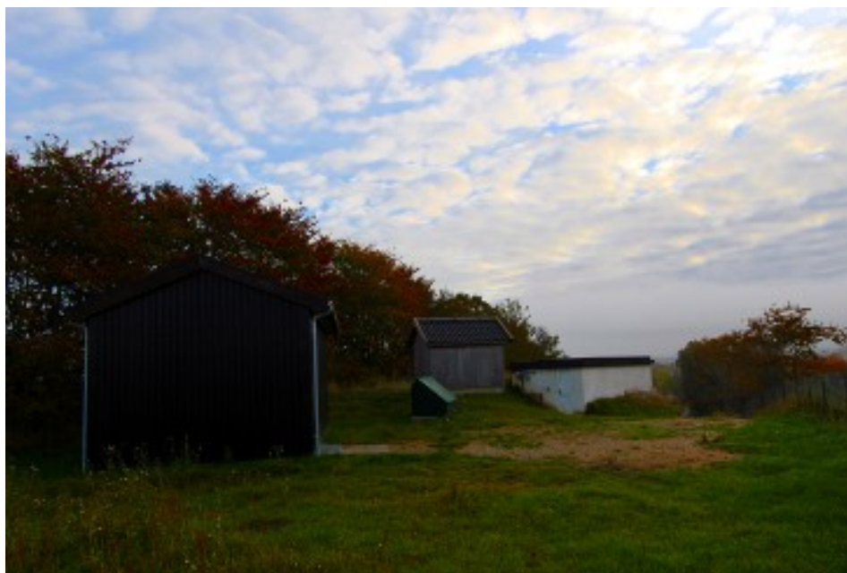
Foto af Esrum vandværk
